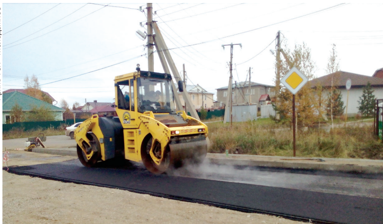
Рабочая группа Правления совместно со строителями-дорожниками определяет пути решения проблем и следит за ходом производства работ.
