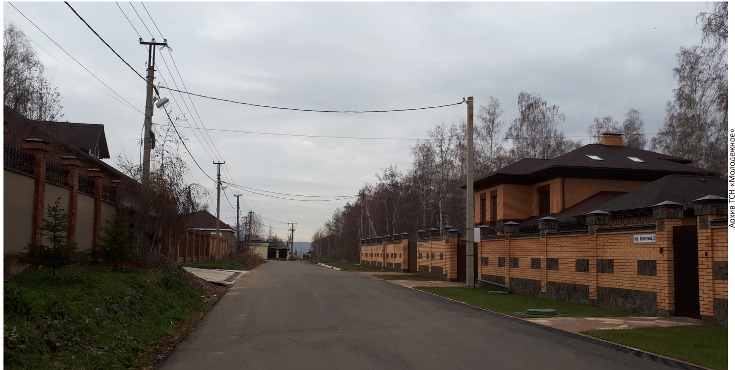
То, что дороги активно ремонтируются, факт.
